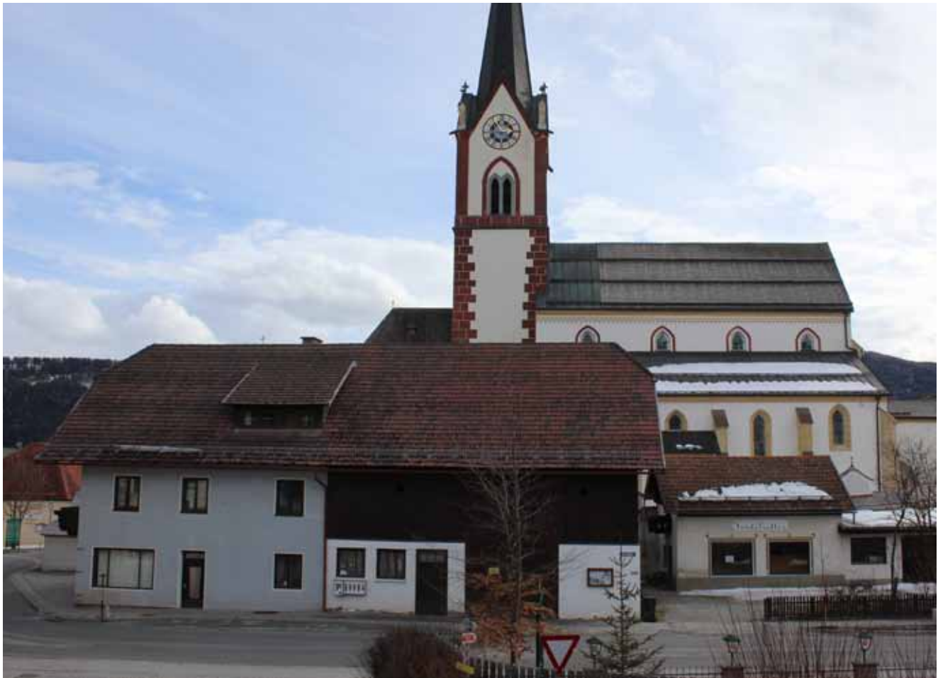
Der Abbruch des Ausweger-Hauses im Ortskern von Mariapfarr erfolgt im Mai 2018. Im hinteren Teil (rechts), der ehemaligen Blumenstube, waren bis vor Kurzem die Trödelretter untergebracht.
